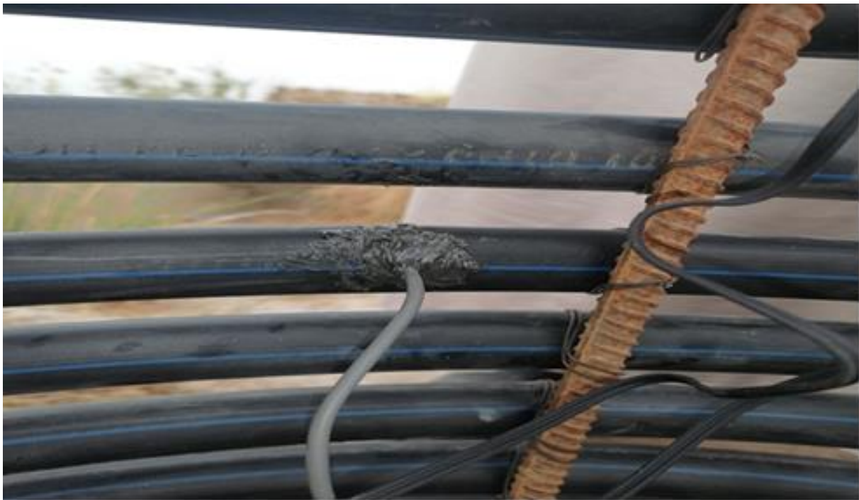
Figure.5: Capteurs de mesure de température à l'intérieur de l'échangeur (source: l'auteur).
