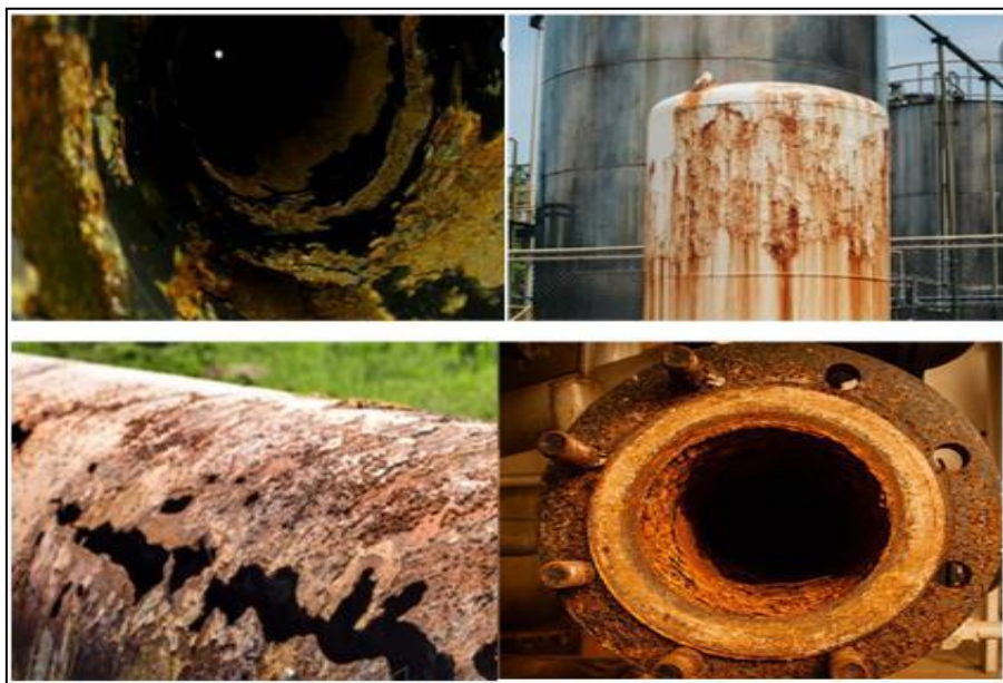
Figure I-1 : Différentes formes de corrosion [24].
