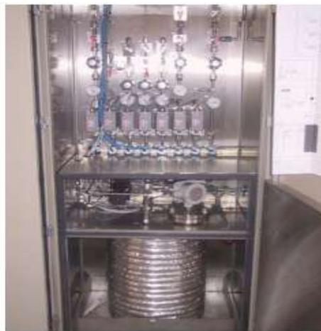
**Figure III.1:** Evaporateur  $\text{TiCl}_4$  et débitmètres.
